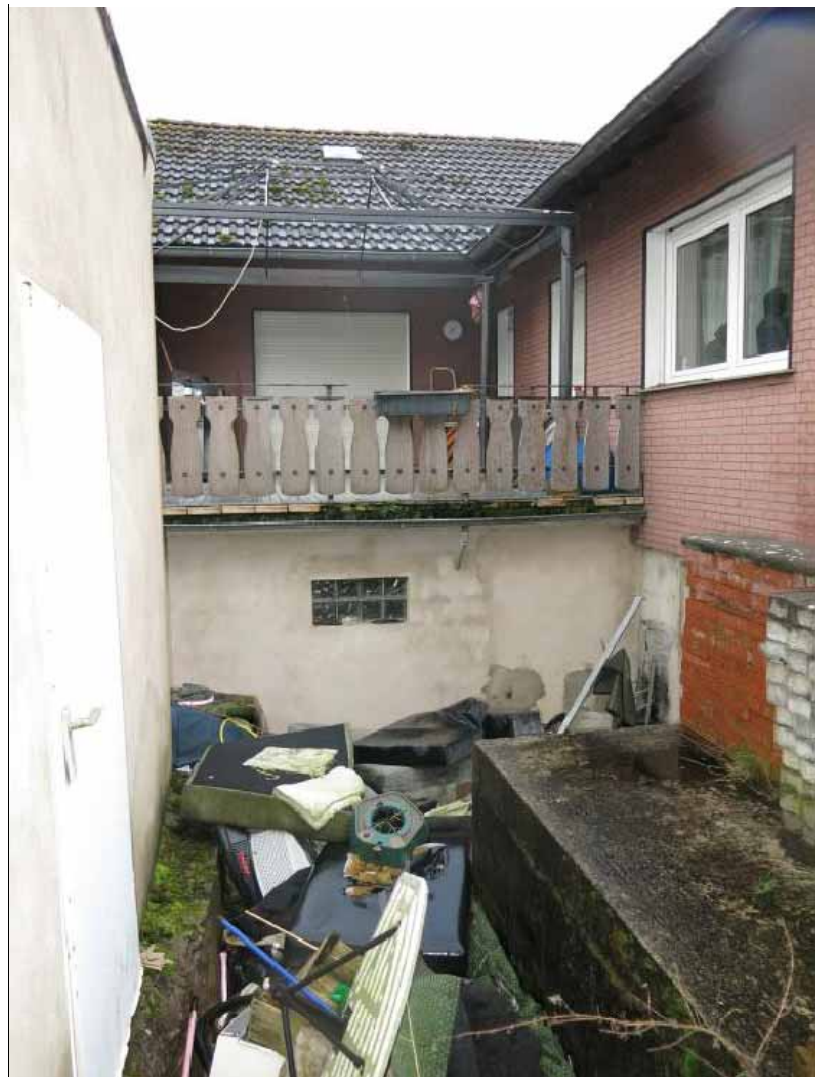
„Hinterhof“ mit Blick zur Terrasse auf Kellerraum (links die Gragen)
