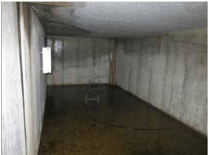
„Außenkeller“ von innen (älteres Foto; ca. 30 cm stehendes Wasser (links der Heizkörper an der Wand!))
